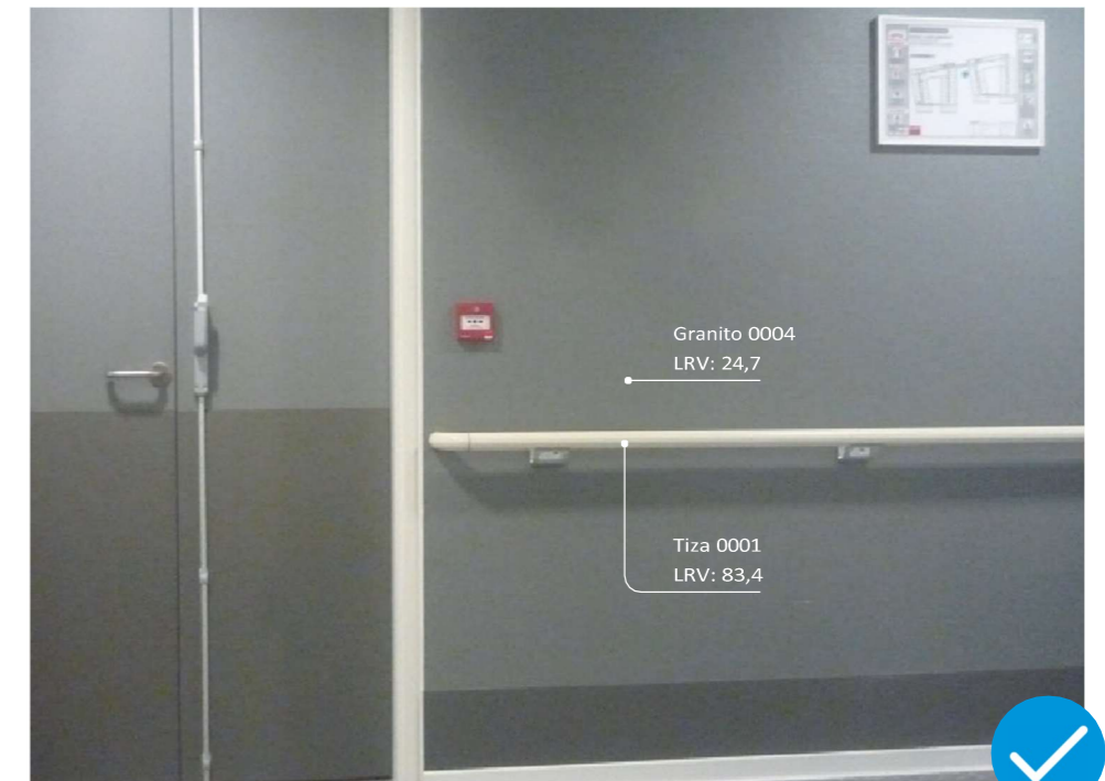
Diferencia de coeficiente LRV entre pasamanos y pared >30 puntos
